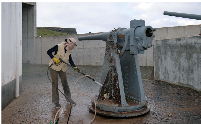
Figura 5. Eliminación de las capas de repinte e imprimación realizada mediante proyección de arena de sílice. Esta operación, de carácter invasivo, obedece a la sustitución de conceptos como la mínima intervención o reversibilidad de los materiales por otros como la necesidad de permanencia. Esta permuta justifica la aplicación de procedimientos y el uso de materiales duraderos que garantizan la estabilización de los artefactos, procurando prolongar en el tiempo las acciones ejecutadas y reduciendo los costes y recursos empleados en su conservación
