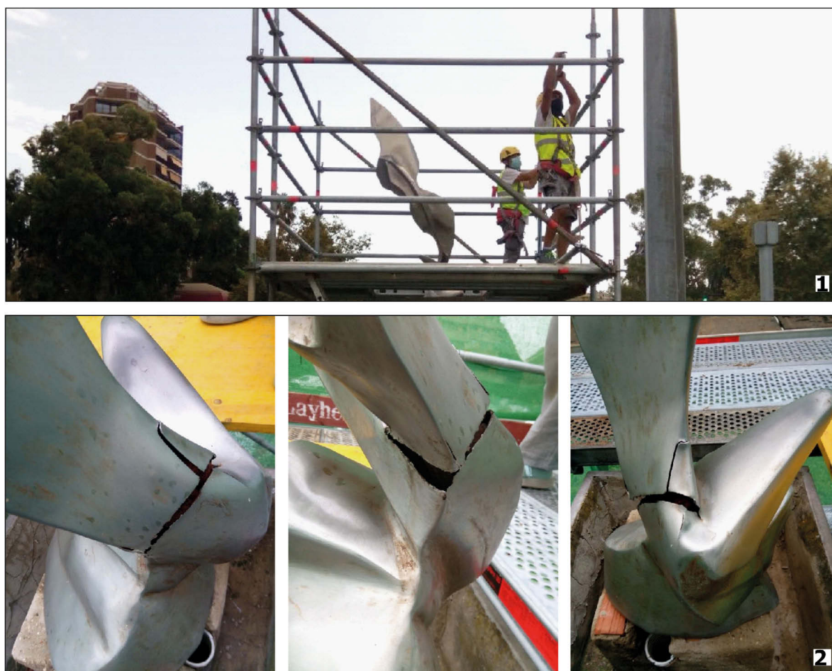
Figura 4. 4.1. Instalación de andamio tubular estructural para la realización de los trabajos de restauración. 4.2. Detalle desde el andamio de la rotura prácticamente integral de la escultura
