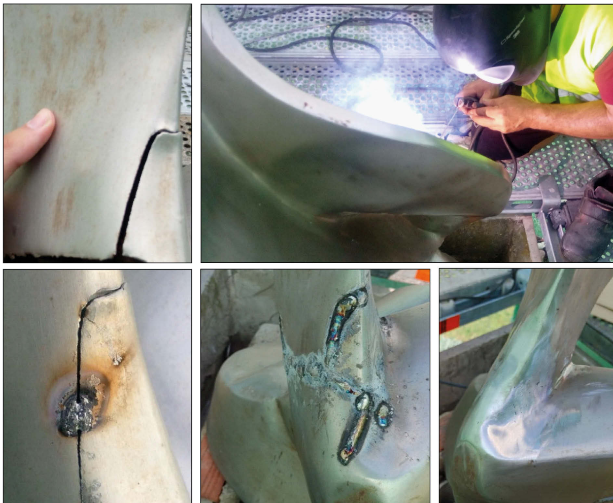
Figura 5. Detalle de los trabajos de soldadura de la rotura partiendo de su recolocación en la posición original con el apoyo del andamio estructural y pequeños puntos de soldadura. Posteriormente vemos el cordón de soldadura completo con aporte de electrodos de acero inoxidable y repaso final de las uniones hasta dejarlas pulidas
