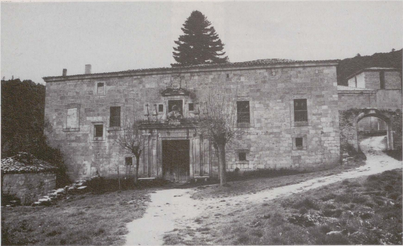
Fig. 8.—Fachada principal del monasterio.
