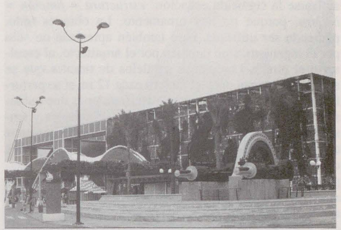
Fig. 23.—Eduardo ARROYO: Intervención en el Pabellón de los Descubrimientos tras el incendio. Febrero-abril de 1992.
