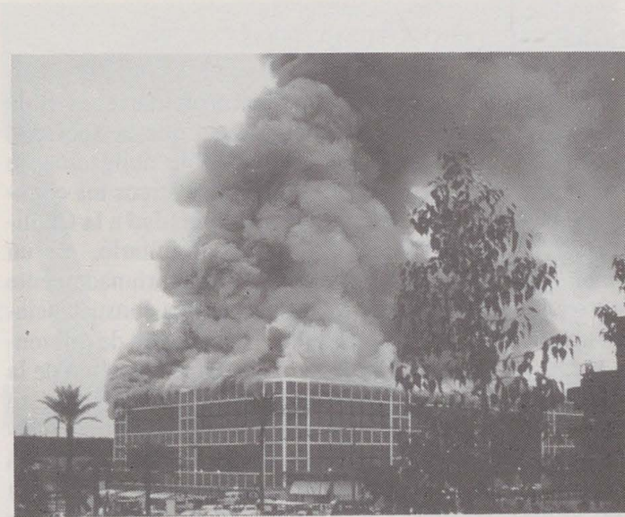
Fig. 22.—Javier FEDUCHI: Pabellón de los Descubrimientos durante el incendio de 18 de febrero de 1992.
