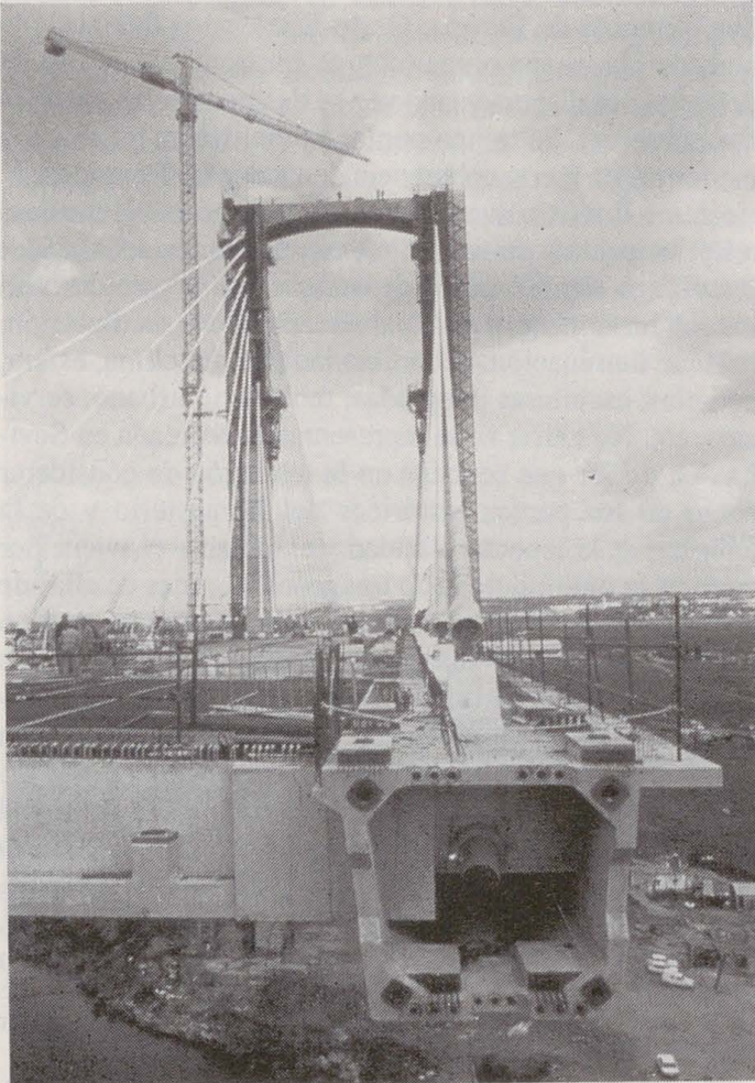
Fig. 15.—José A. FERNÁNDEZ ORDÓÑEZ y Julio MARTÍNEZ CALZÓN: Puente del Centenario . Estructura en fase de construcción.
