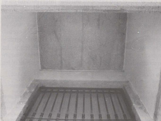
Fig. 10. Ruptura del piso del Patio de Mascarones por la ventana nueva del Panteón del Escorial.
