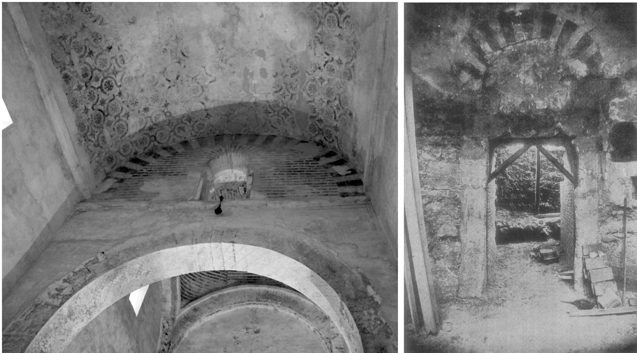
Fig. 4. Simulaciones de arcos de ladrillo y piedra: a la izquierda, en la iglesia de Santiago de Peñalba; a la derecha, en la iglesia de San Cebrián de Mazote (M. F. Solano, “La reconstrucción de San Cebrián de Mazote”, Boletín del Seminario de Estudios de Arte y Arqueología , II, primer trimestre, facs. IV, 1933, pp. 95-98)
