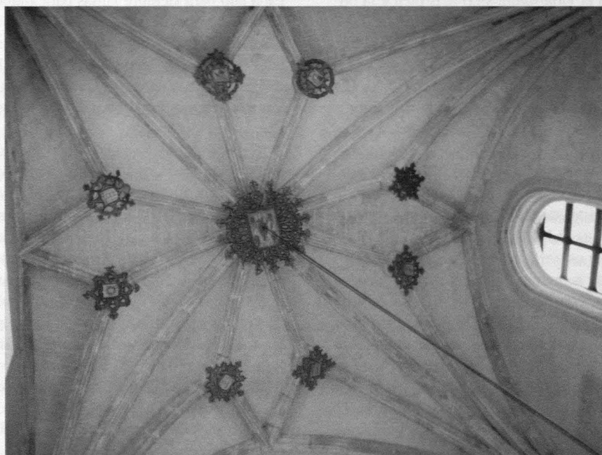
Fig. 3. Bóveda de la capilla y detalle de las claves.
