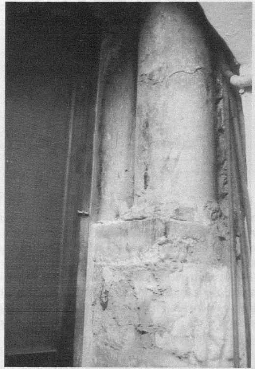
Fig. 14. Arranque de las columnas del arco del lado sur de la Capilla Real de Córdoba, en la cripta de la misma.
