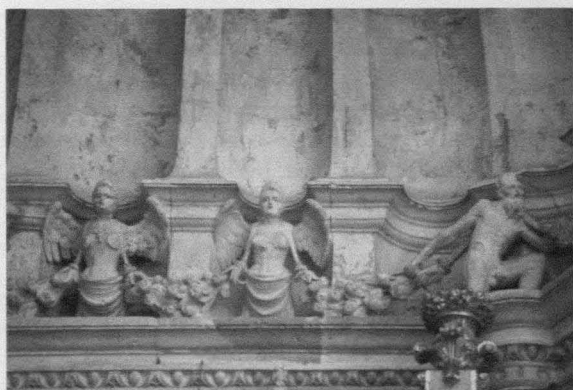
Fig. 10. Cubierta en venera de la capilla mayor de La Vid: detalles escultóricos del arranque
