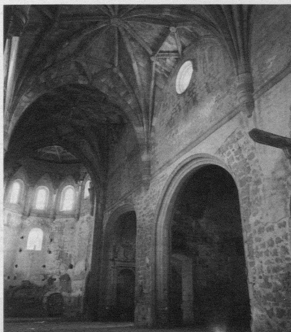
Fig. 3. Interior de la iglesia de S. Francisco hacia el altar principal.
