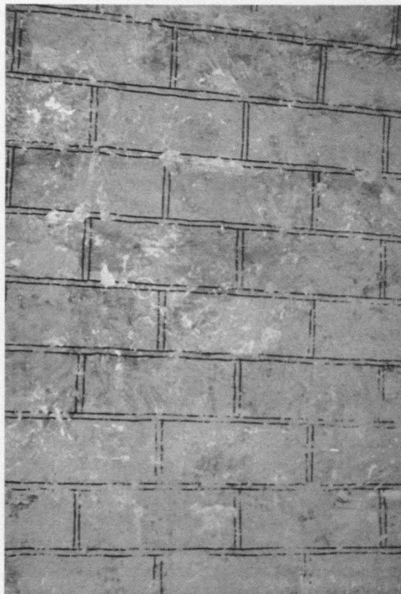
Fig. 1. Catedral de Toledo, "canteado" original en el arco de ingreso de la capilla de San Pedro.
