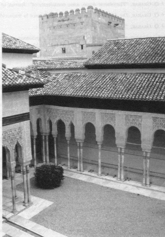
Fig. 13. Ángulo N-W del Patio de los Leones.
