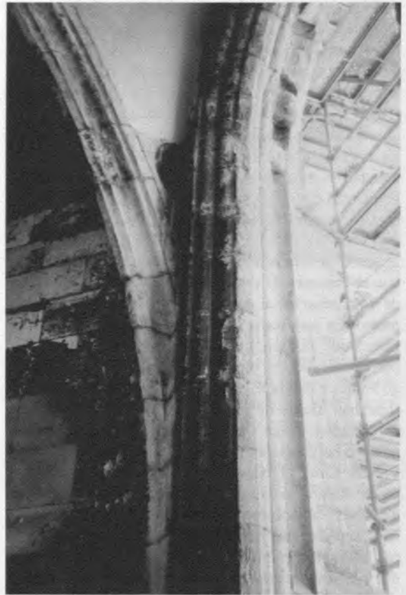
Fig. 13. Nervio-estribo angular, torre sur (cuerpo superior).
