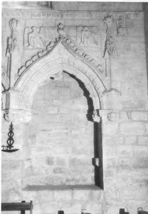
Fig. 5. Arcosolio del costado meridional.
