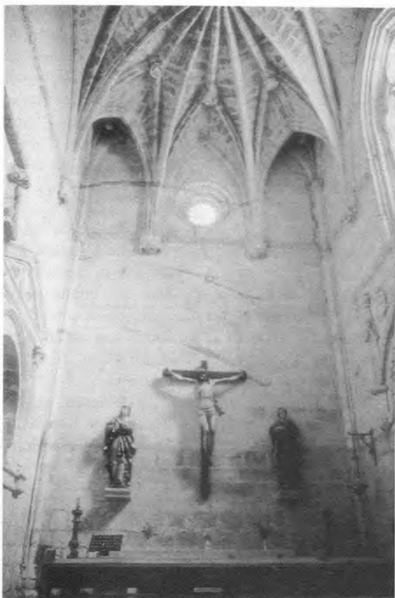
Fig. 3. Vista general hasta el este.
