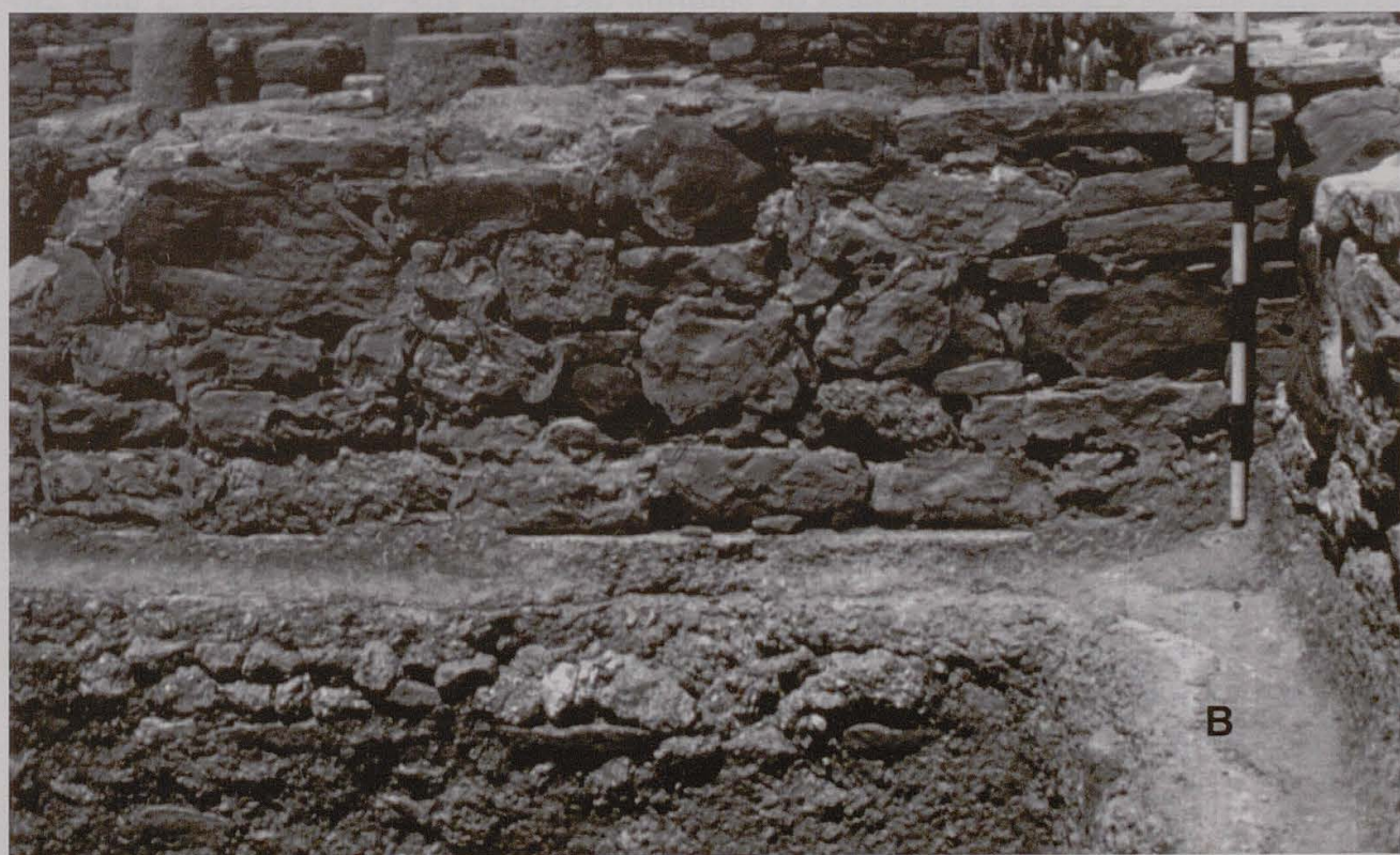
Figura 14. Detalles constructivos del Conjunto Industrial IV. A. Paramento frontal del muro perimetral norte realizado en vittatum de caliza gris. B. Parámetros de incertum de caliza y arenisca en el ángulo noroccidental del C.IV, con un detalle de la amortización de un suelo de signinum anterior a la construcción general del espacio.
