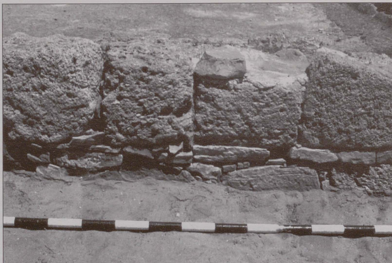
Figura 12 A. Detalles constructivos del Conjunto Industrial I. Parámetro frontal meridional del muro perimetral sur, con opus vittatum en la parte inferior y un recrecimiento de ostonera en la parte superior.
