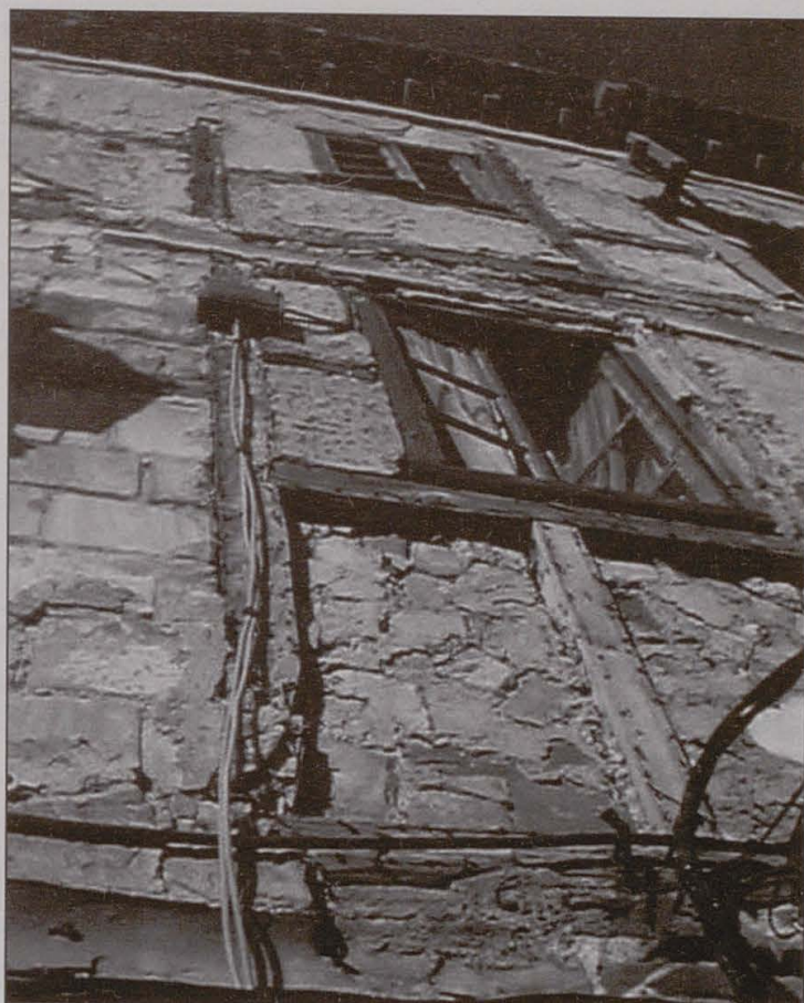
Figura 4. Detalle de la fachada principal
