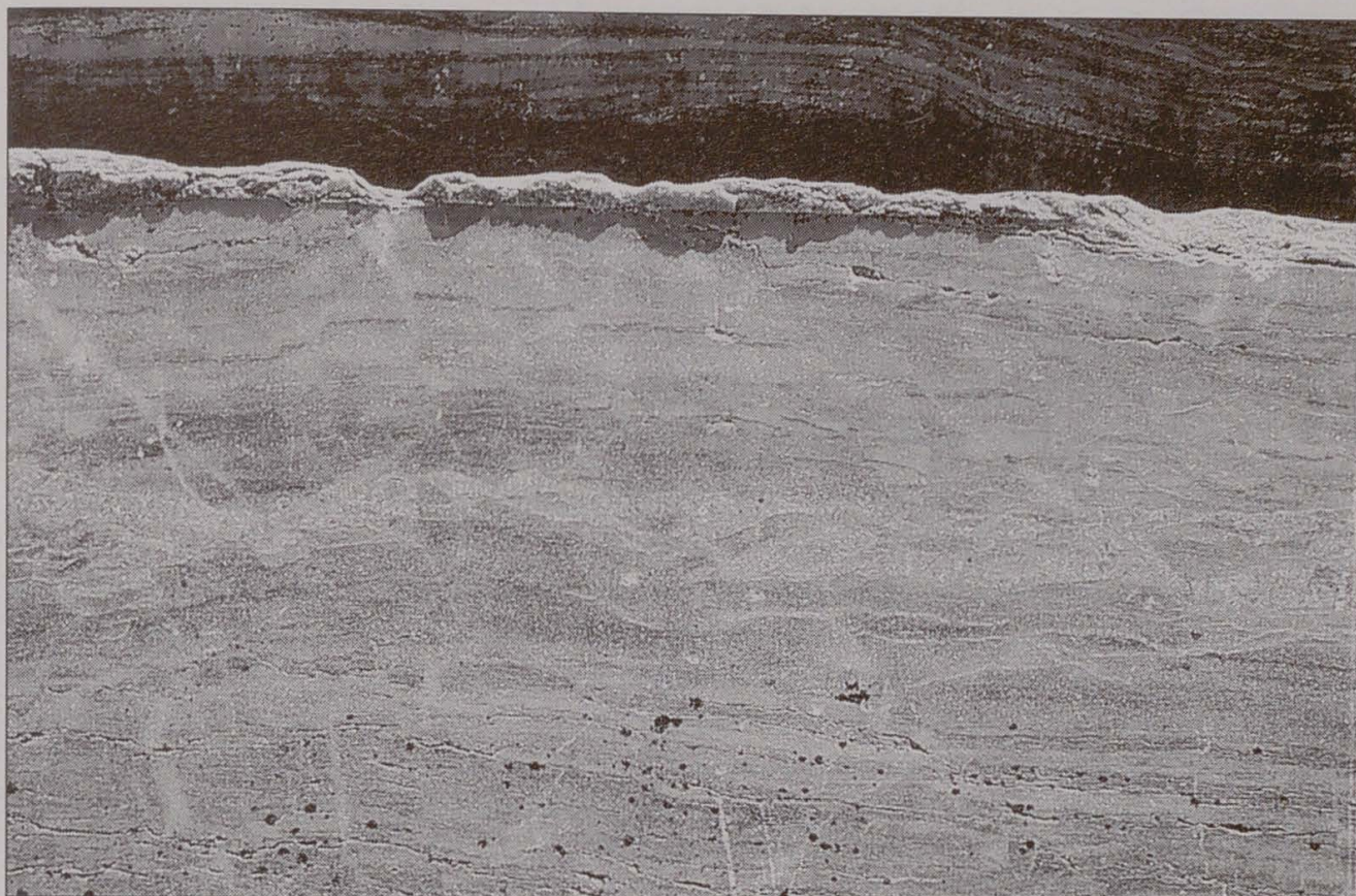
Figura 18. —Fragmento de fuste de columna en el que se aprecia la línea irregular de rotura dejada tras el serrado de la pieza
