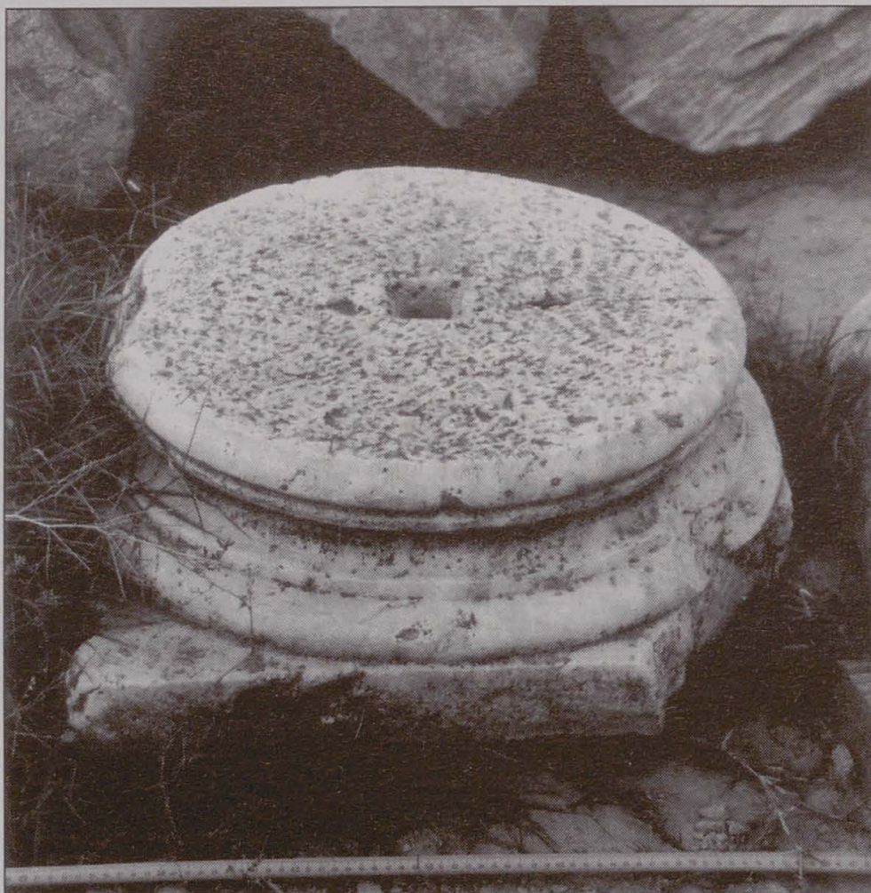
Figura 12. —Basa del orden inferior de la scaenae frons del teatro romano de Itálica con orificio central para asegurar la unión con su fuste correspondiente
