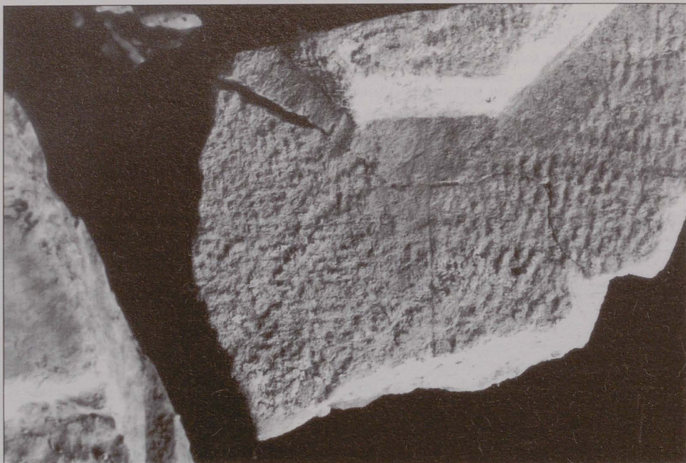
Figura 8. —Nuevo detalle del capitel anterior en el que se aprecian las líneas rectas que en la superficie del ábaco indican la disposición de sus esquinas
