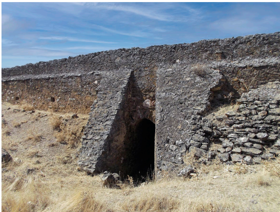
Figura 6. Puente reforzado para el paso de carretas con azogue cercano a Almadén. (© Proyecto Galeones de Azogue. Foto: C. León, 2017)
