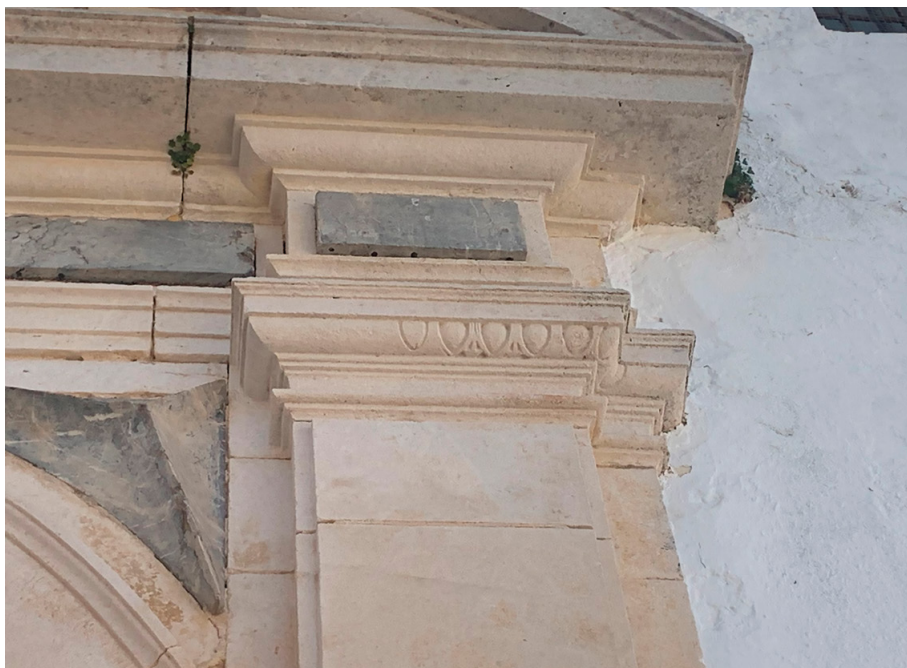
Figura 7. Decoración sin finalizar en una imposta de la Iglesia barroca de Nuestra Señora de la Asunción (Montemayor, Córdoba). Obsérvese cómo hay ovas talladas, otras trazadas y partes del elemento arquitectónico que han quedado sin decorar. (Autores)
