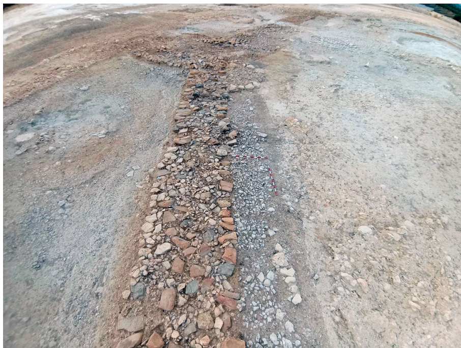
Figura 6. Vista de cimentación de la Muralla 2
