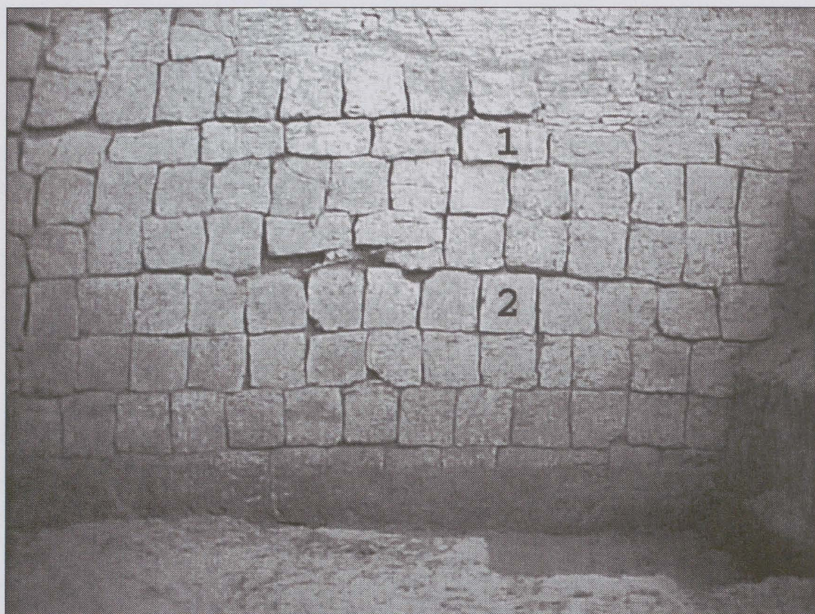
Fig. 11. Bâtiment nord, mur sud, briques verticales.
